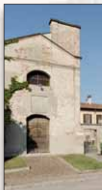
Montanaso: la chiesa sconsacrata del sec. XVI. Era dedicata di San Giorgio Martire.
