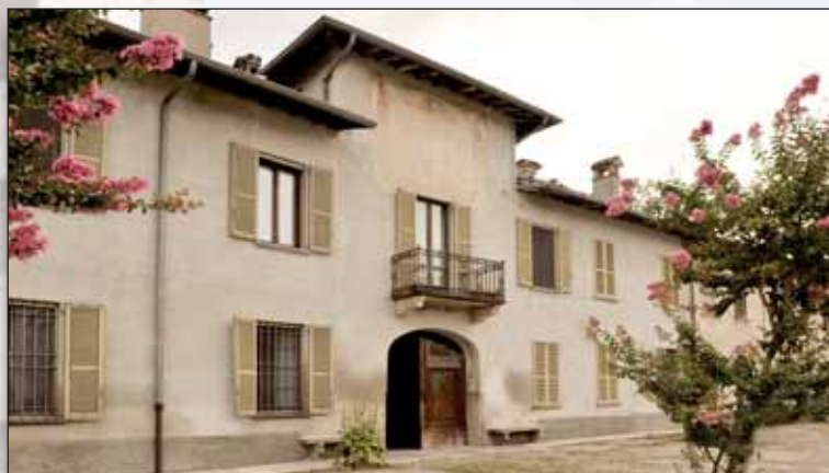
Corte Palasio: in alto e a lato, la facciata di Palazzo Barni o dei Vescovi sec. XVIII.
