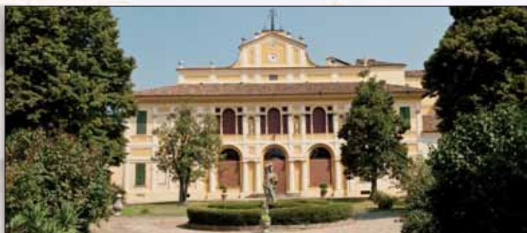
Crotta d'Adda: facciata di Villa Stanga.
