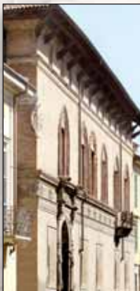
Lodi: scorcio del rinascimentale Palazzo Mozzanica.
