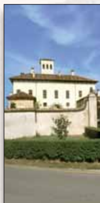
Merlino: alla frazione Marzano, Ingresso di Palazzo Carcassola.
