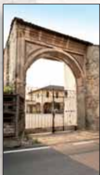
Portale di ingresso di antica dimora.
