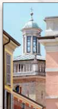
Lodi: la lanterna della cupola dell'Incoronata.
